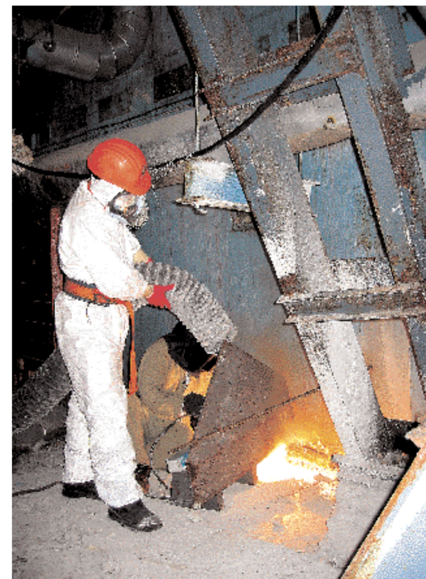
La radiación sigue escapando de Chernóbil. Esta imagen exclusiva es la prueba de los trabajos que, hace menos de 20 días, se producían en el interior de la central para sellar el 'sarcófago' y frenar la salida de agentes tóxicos.
